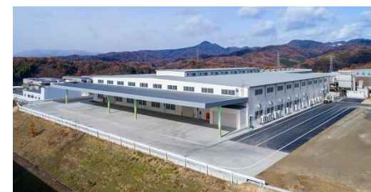
➤ 福山工場 加工棟建設
