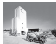
◀コンクリートプラント
