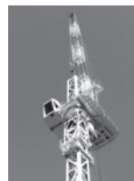
▲ジブクレーン
