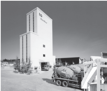
▲コンクリートプラント
