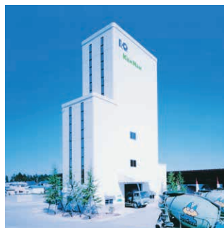
▲コンクリートプラント
