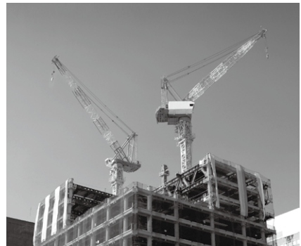
ビル建設用タワークレーン ▶
