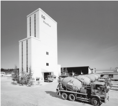
▲コンクリートプラント
