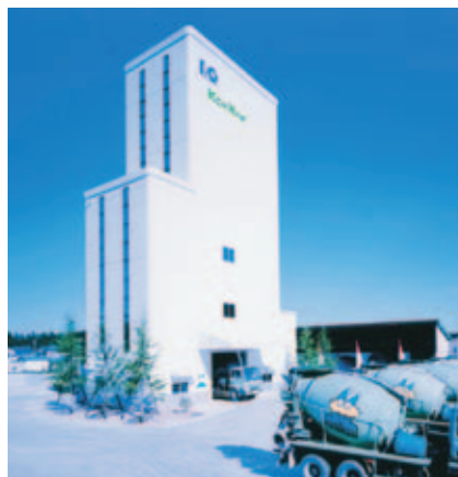
▲コンクリートプラント
