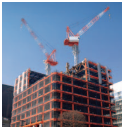
▲ビル建設用タワークレーン
