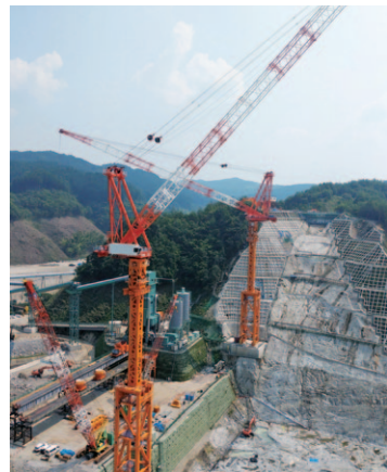
▲ダム建設用タワークレーン
