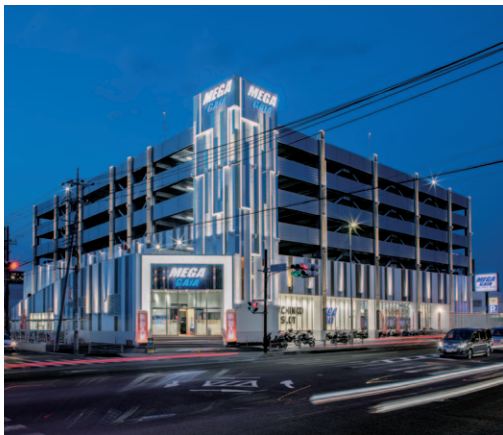
▲自走式立体駐車場
