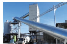
コンクリートプラント
