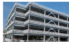
自走式立体駐車場
