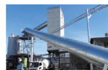
コンクリートプラント
