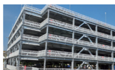
自走式立体駐車場
