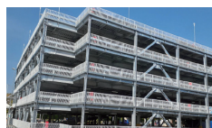
自走式立体駐車場
