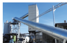
コンクリートプラント
