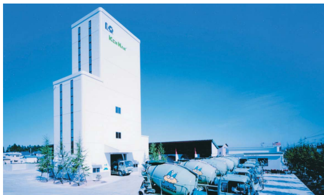
▲コンクリートプラント
