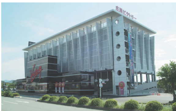
▲施設併用立体駐車場
