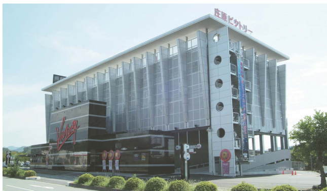
▲施設併用立体駐車場
