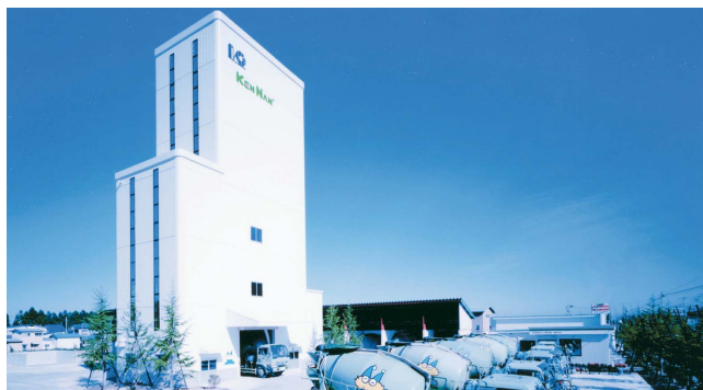
▲コンクリートプラント
