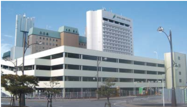
▲自走式立体駐車場
