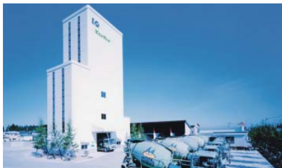
▲コンクリートプラント
