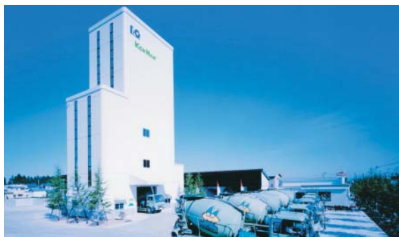
▲コンクリートプラント
