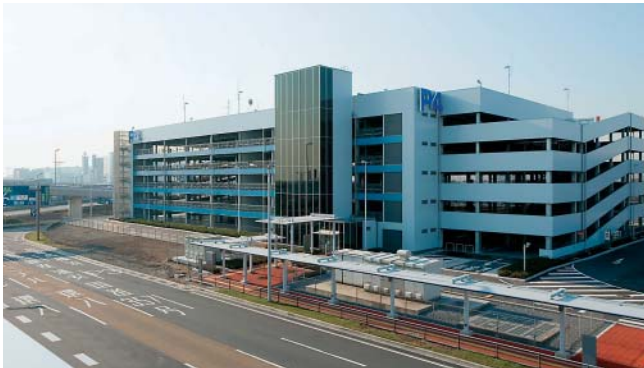
▲自走式立体駐車場
